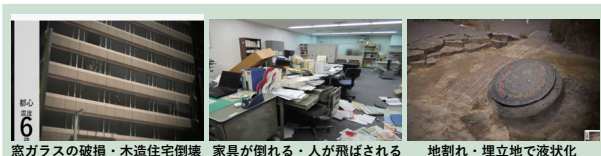
窓ガラスの破損
